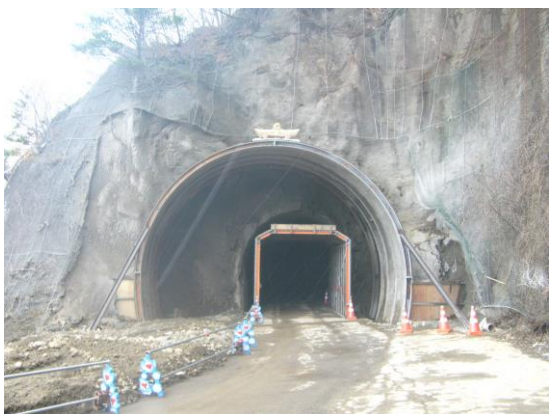
写真-5 鋼製プロテクター設置状況
