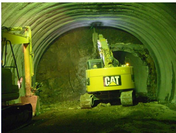
写真-3 全断面掘削工法による掘削状況
