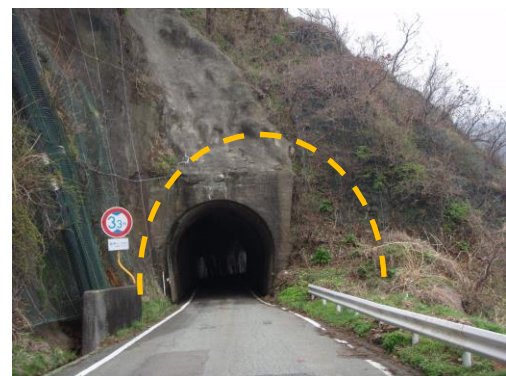
写真-1 拡幅工事着手前「跳坂隧道」
