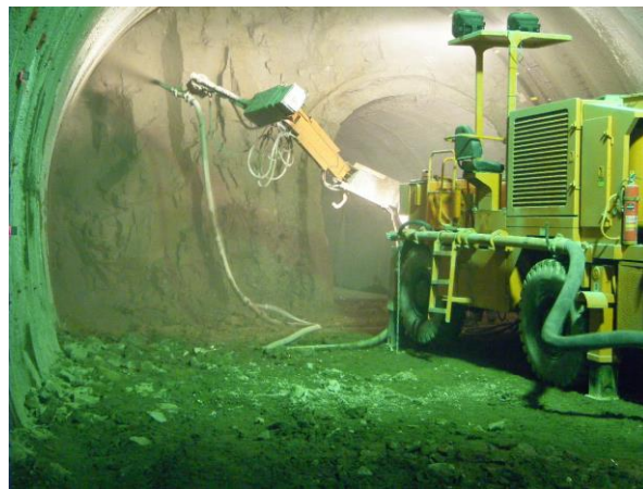
写真-4 鏡吹付状況
