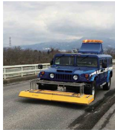
図-2 床板高速点検車
