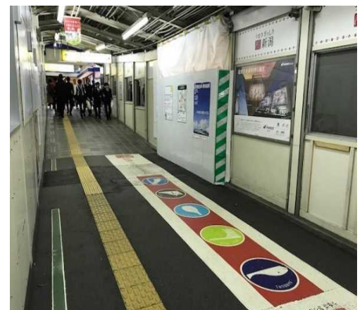
図-6 着手前の様子
