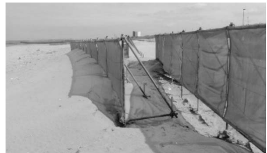
写真-4 仮設堆砂垣
