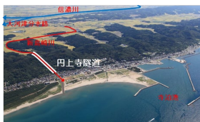
（円上寺隧道の周辺状況）
