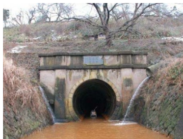
（吐口（下流側）隧道ポータル）
