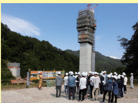
【工事名】国道289号5号橋梁下部その2工事 【発注者】北陸地方整備局(長岡国道事務所) 【施工者】株式会社 大林組
