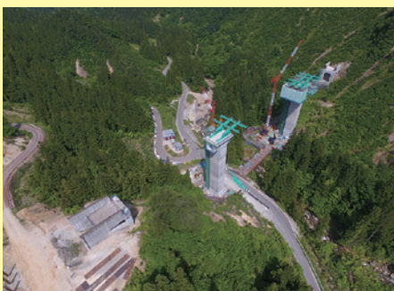
【工事名】国道289号2号橋梁上部工事 【発注者】北陸地方整備局(長岡国道事務所) 【施工者】株式会社 安藤・間
